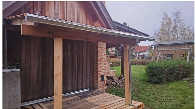
Abb 3: Das Dach mit Trapezblech und Dachrinne ist fertig, das Holz kann kommen
