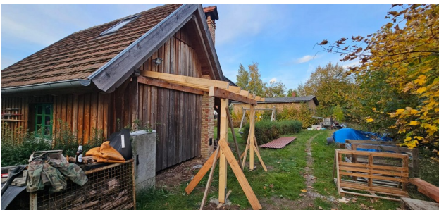
Abb 2: Bodenhülsen halten die Stiele, die Sparren sind montiert
