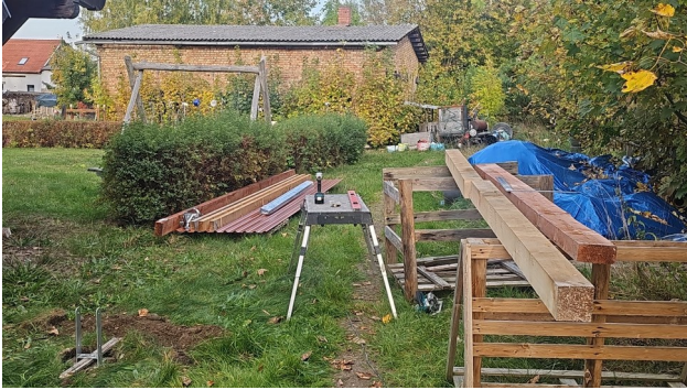
Abb 1: Kanthölzer warten auf den Zuschnitt
